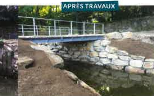
le démantèlement du clapet de Penhoët
