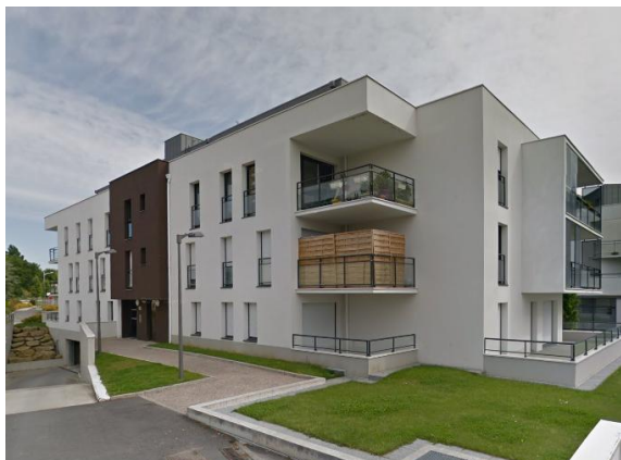
Logements collectifs Av du Gal De Gaulle
