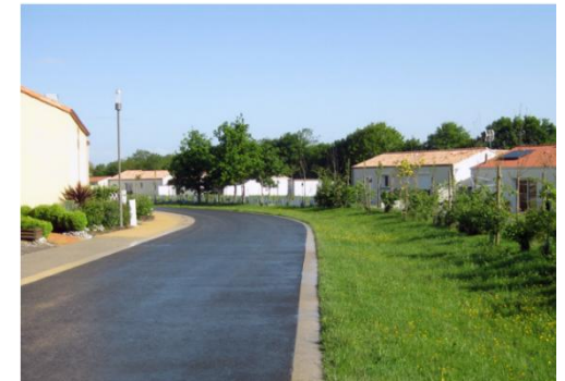
Voie principale avec trottoir et noue Treize-Septiers (85)
