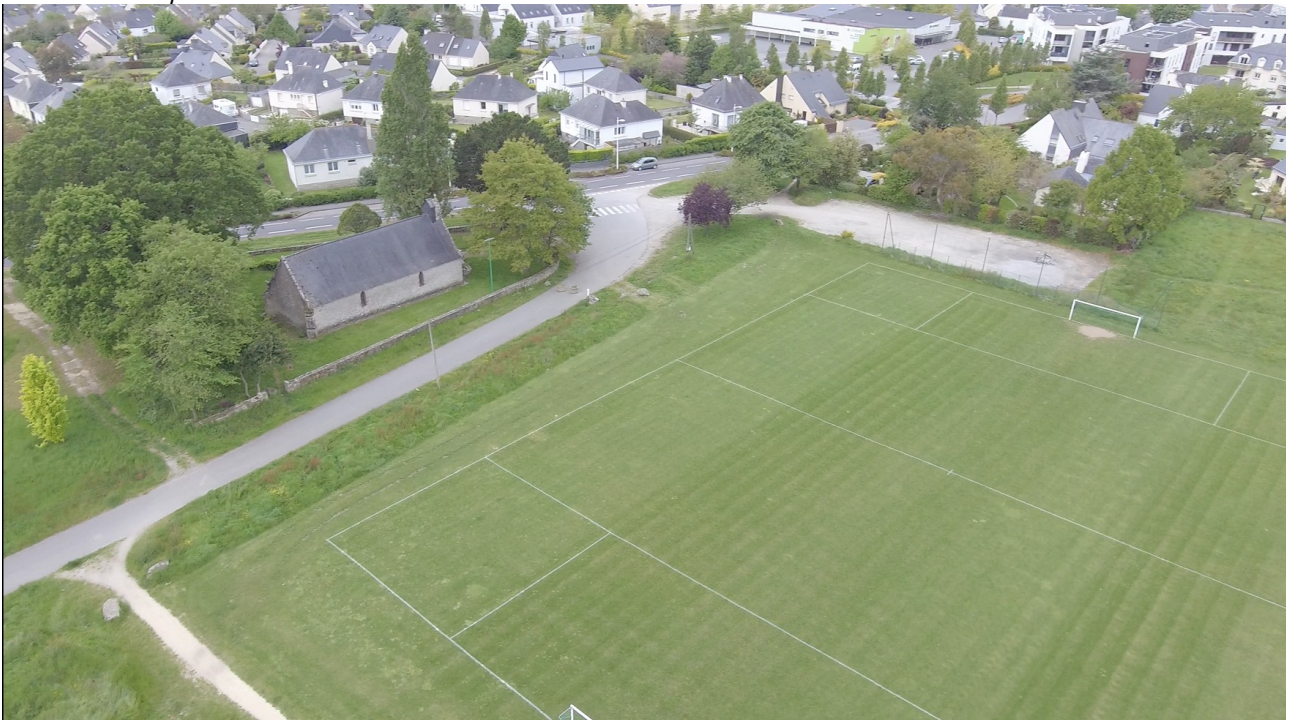
Vue du site depuis le Nord-Est
